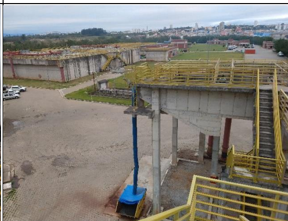
Foto 82: Caçamba utilizada para acondicionamento da areia na ETE Central (16/09/2021).
