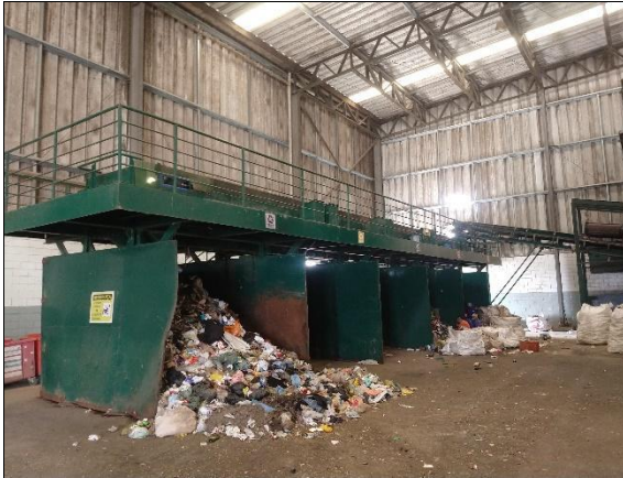
Foto 32: UTMB – estação de triagem manual (15/09/2021).
