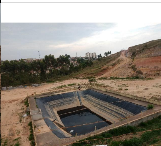
Foto 59: aterro sanitário em operação – impermeabilização da base (15/09/2021).
