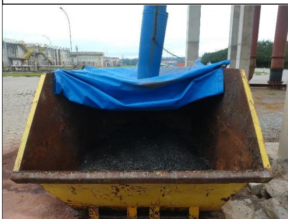
Foto 83: Caçamba de 3 m 3 com areia na ETE Central (16/09/2021).
