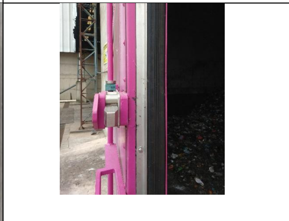
Foto 47: UTMB – estrutura de vedação (15/09/2021).
