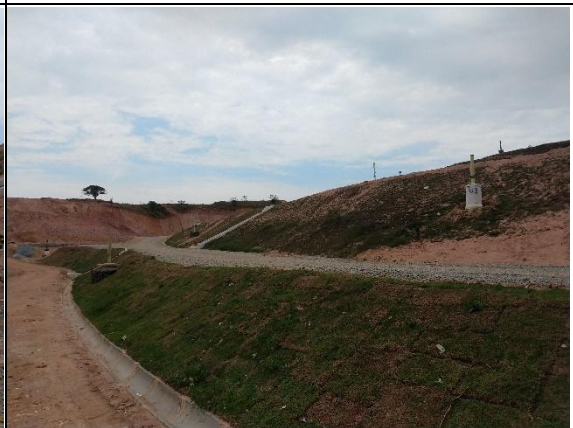
Foto 57: aterro sanitário em operação - berma e sistema de drenagem (15/09/2021).
