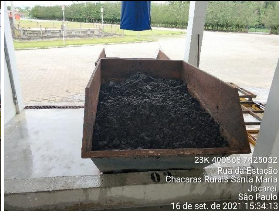
Foto 86: Lodo desaguado na ETE Central.
