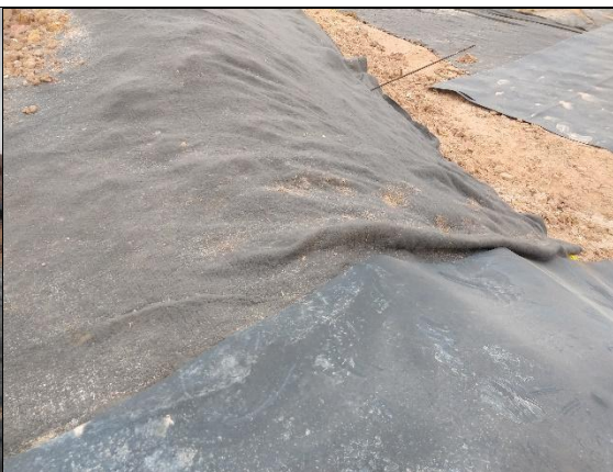
Foto 59: aterro sanitário em operação – impermeabilização da base (15/09/2021).
