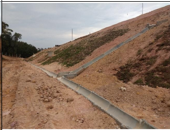
Foto 55: aterro sanitário em operação – sistema de drenagem pluvial (15/09/2021).
