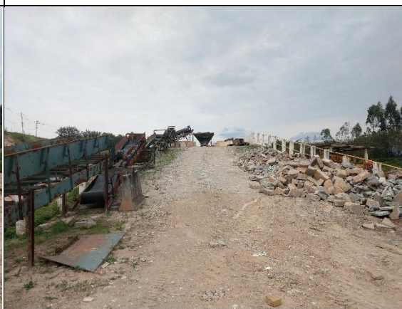
Foto 114: Esteiras de RCC (15/09/2021).
