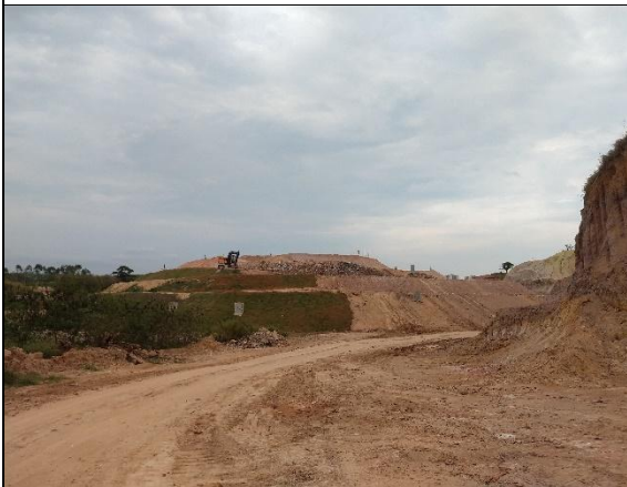
Foto 54: aterro sanitário em operação – frente de trabalho (15/09/2021).
