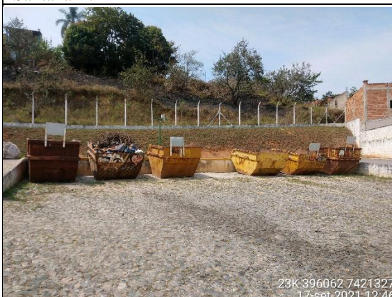
Foto 108: Caçambas para armazenamento temporário dos resíduos.
