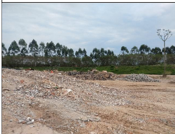
Foto 113: Pátio utilizado para armazenamento de RCC (15/09/2021).
