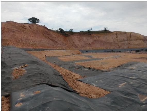
Foto 58: aterro sanitário em operação – impermeabilização da base (15/09/2021).
